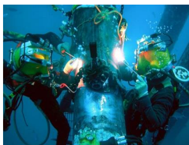
Рисунок 9 – Сварка под водой [1]
